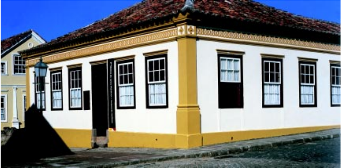
Figura 2. A Casa da Cultura, outro monumento histórico paranaense, também foi incluída no estudo sobre a biodeterioração
